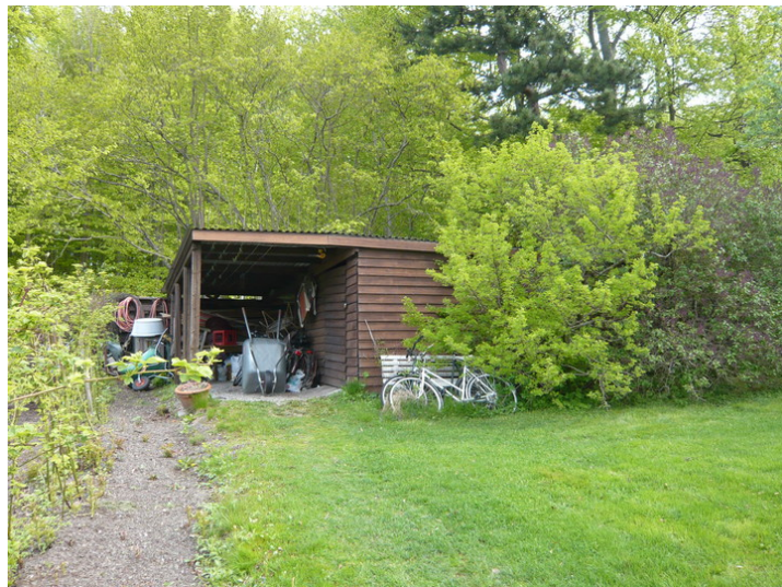
Redskapsboden mot sør. Opphavsrett: Statsbygg.
