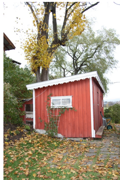
Uthus 2. Opphavsrett: Statsbygg.
