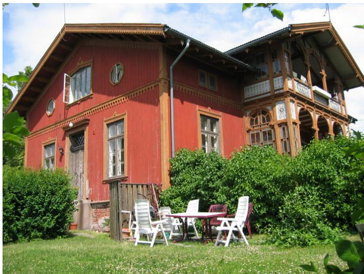
Fasade sør/øst. Opphavsrett: Statsbygg.
