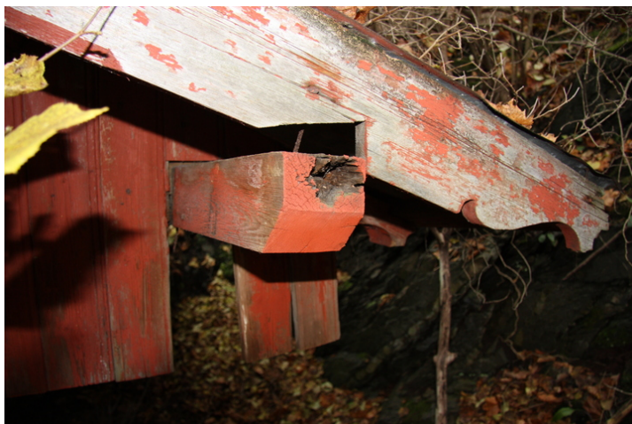
Detalj utedo. Opphavsrett: Statsbygg.
