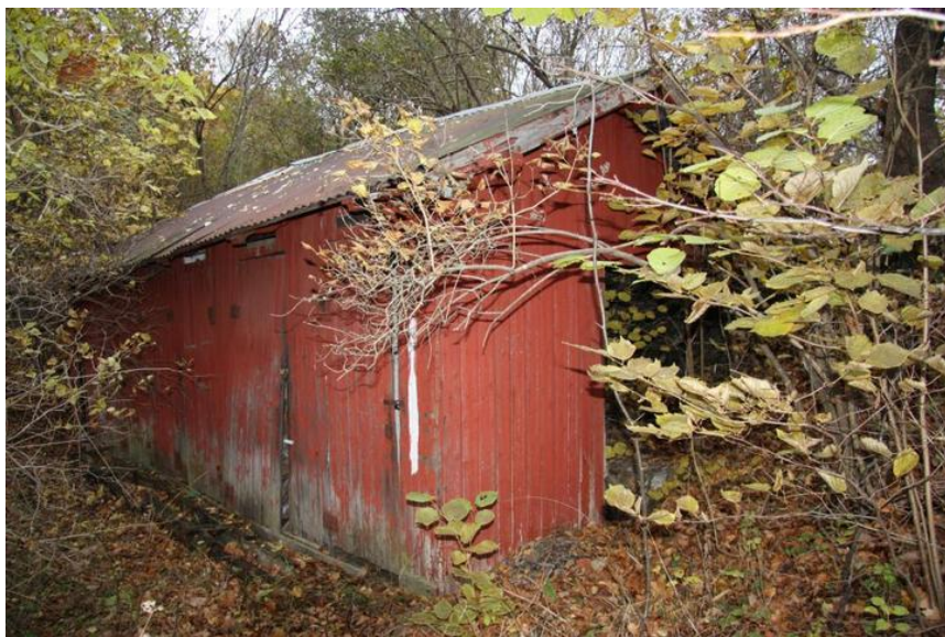
Utedo med plass til flere. Opphavsrett: Statsbygg.
