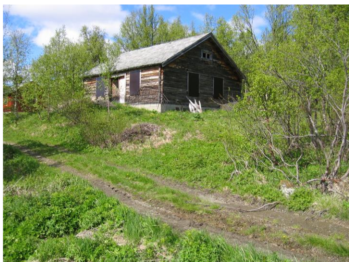
Nordøstlig fasade. Opphavsrett: Statsbygg.
