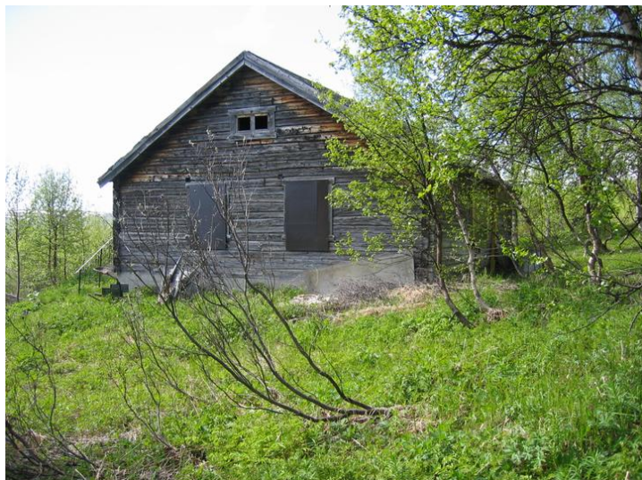
Nordøstlig fasade. Opphavsrett: Statsbygg.
