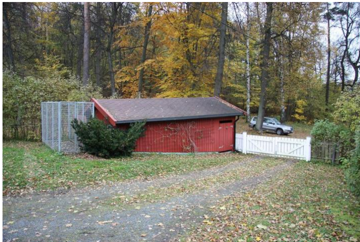
Fasaden mot vest. Opphavsrett: Statsbygg.
