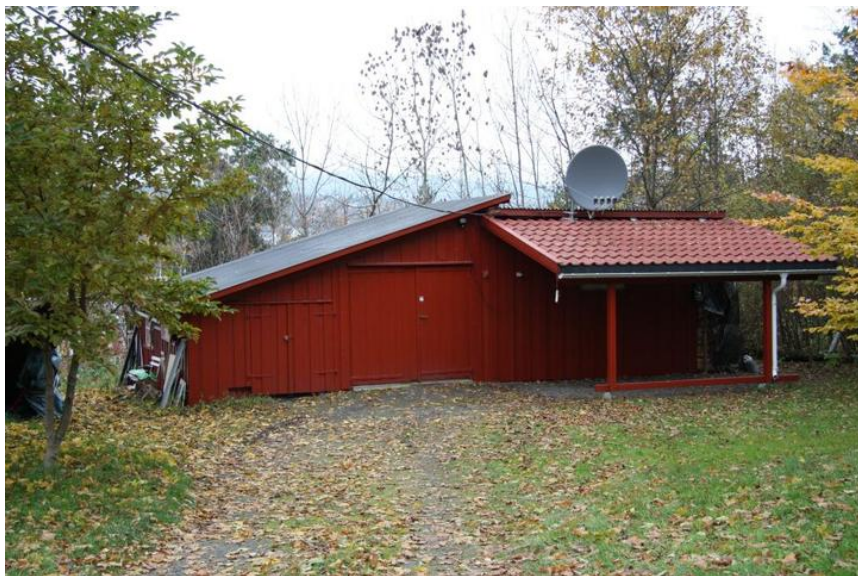
Carport med rød takstein til høyre i bildet. Opphavsrett: Statsbygg.
