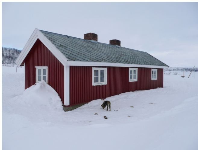
Langvegg mot sør. Opphavsrett: Statsbygg.
