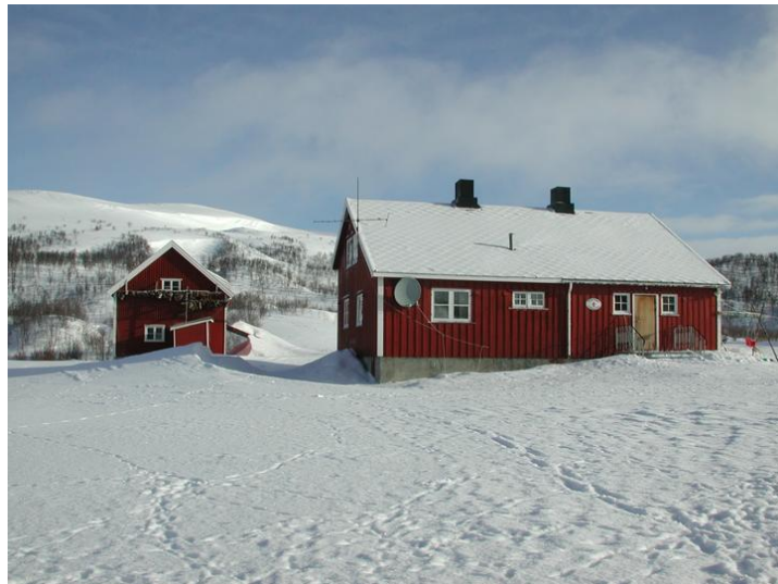
Driftsbygningen og oppsitterboligen mot sør. Opphavsrett: Statsbygg.
