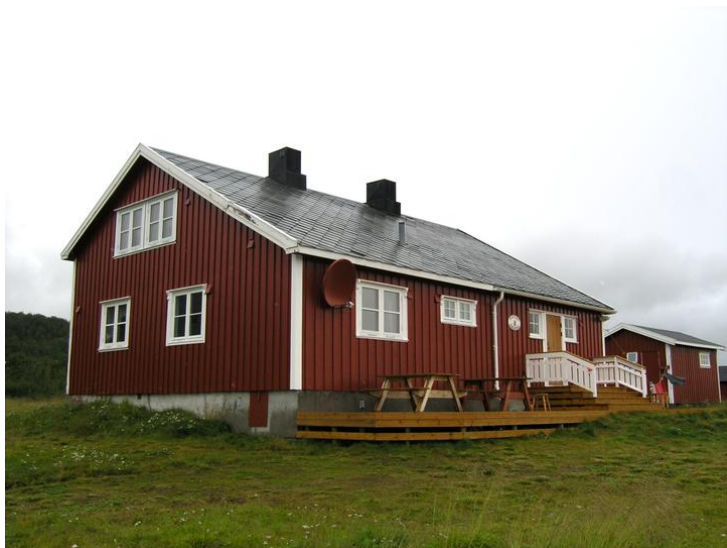
Fasade mot sør. Nyere inngangsparti. Opphavsrett: Statsbygg.
