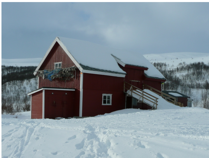
Driftsbygningens fasade mot tunet, sørøst. Deler av 1. etg. er laftet. Opphavsrett: Statsbygg.
