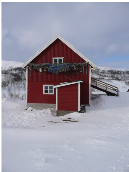
Fasaden mot sør. Nyere utedotilbygg. Opphavsrett: Statsbygg.
