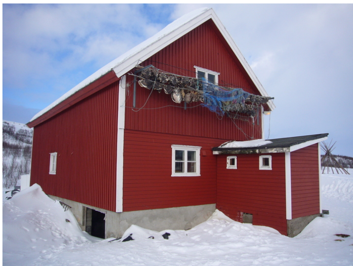
Fasader mot sør og vest. Eldre vinduer i hele bygningen. Opphavsrett: Statsbygg.
