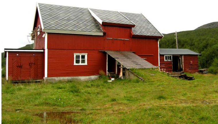
Fasade mot øst med låvebru. Opphavsrett: Statsbygg.
