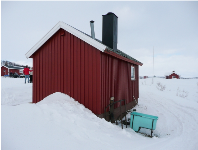
Fasader mot vest og sør. Opphavsrett: Statsbygg.
