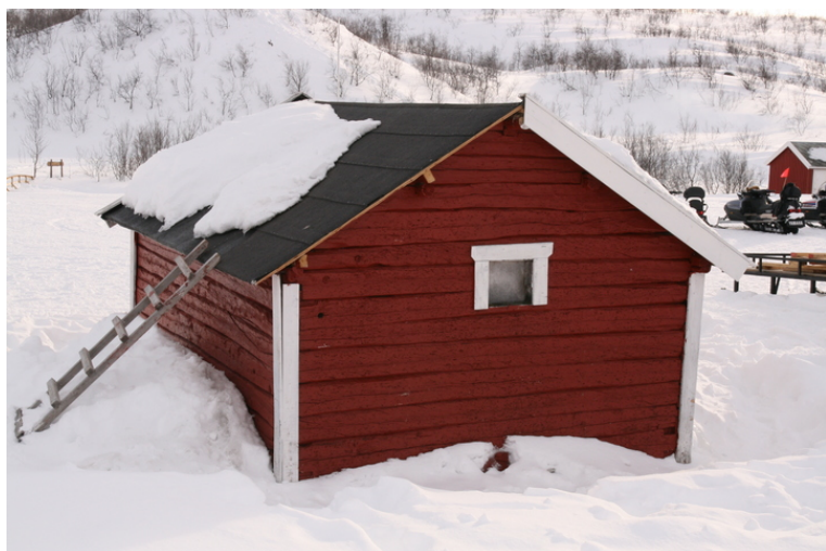
Liten vindusåpning i vegg mot nord. Opphavsrett: Statsbygg.
