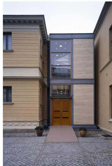
I inngangspartiet til Parkveien 45 er det også innpasset heis. Tilbygd ca 1997. Foto: Jiri Havran. Opphavsrett: Statsbygg.
