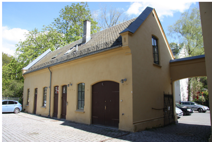
Stallens vestfasade vender inn mot gårdsrommet. Opphavsrett: Statsbygg.
