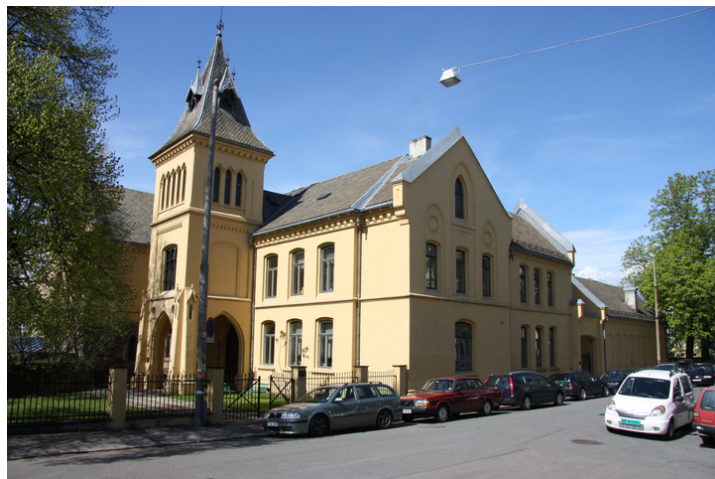
Fasader mot sør og øst. Opphavsrett: Statsbygg.
