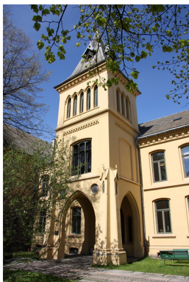
Hovedinngangen i tårnet. I annen etasje har biskopen kontor, og i toppen er det et lite rom med en gotisk vindusrekke. Opphavsrett: Statsbygg.
