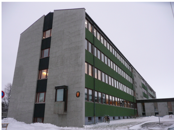
Blokk B med fylkesmannens kontor i 1. etasje med originalt karnapp. Opphavsrett: Statsbygg.
