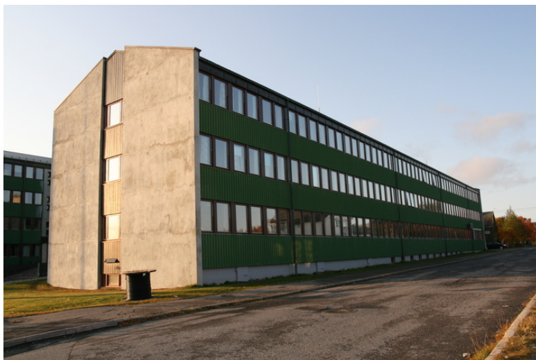
Blokk A. Østfasaden. Dette volumet har opprinnelig eksteriør. Opphavsrett: Statsbygg.
