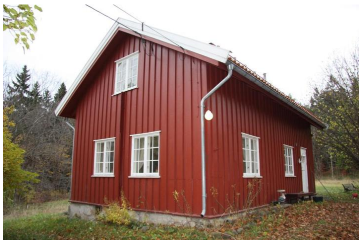
Sørvestfasaden har tre vinduer. Opphavsrett: Statsbygg.
