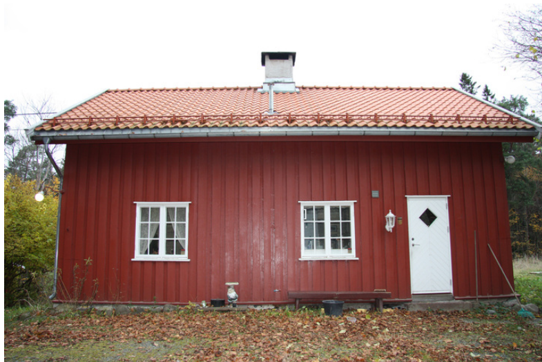
Inngangen er på sørvestre fasade. Delen til høyre med inngangsdøren er i bindingsverk. Taktekkingen er ny. Opphavsrett: Statsbygg.
