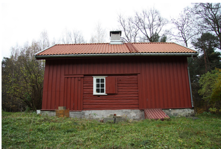
På nordvestfasaden er det et vindu som trolig er originalt. Opphavsrett: Statsbygg.
