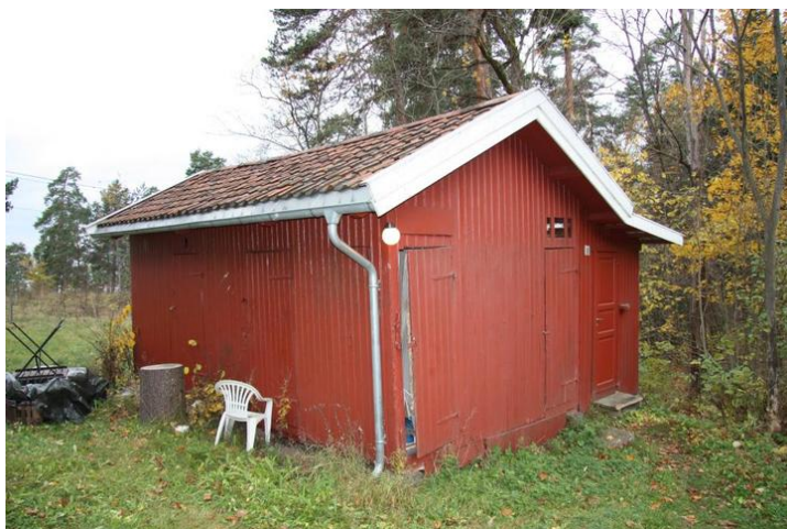
Uthuset med utedo til høyre. Sørøst- og nordøstfasade. Opphavsrett: Statsbygg.
