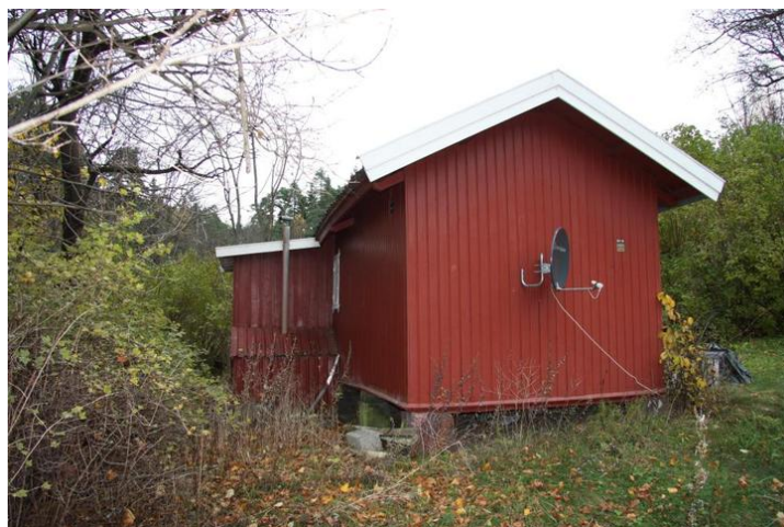
Uthus med tilbygg for utedo. Nordvest- og sørvestfasade. Opphavsrett: Statsbygg.
