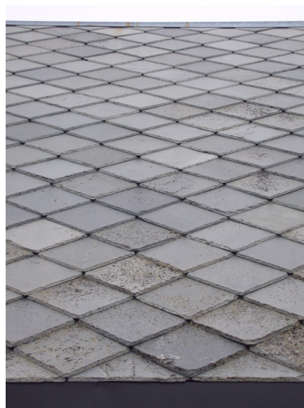
Skifertak. Opphavsrett: Statsbygg.
