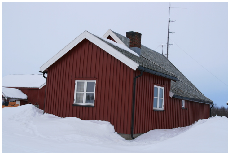
Folkestuetilbygget i forgrunnen. Fasader mot nordvest. Opphavsrett: Statsbygg.
