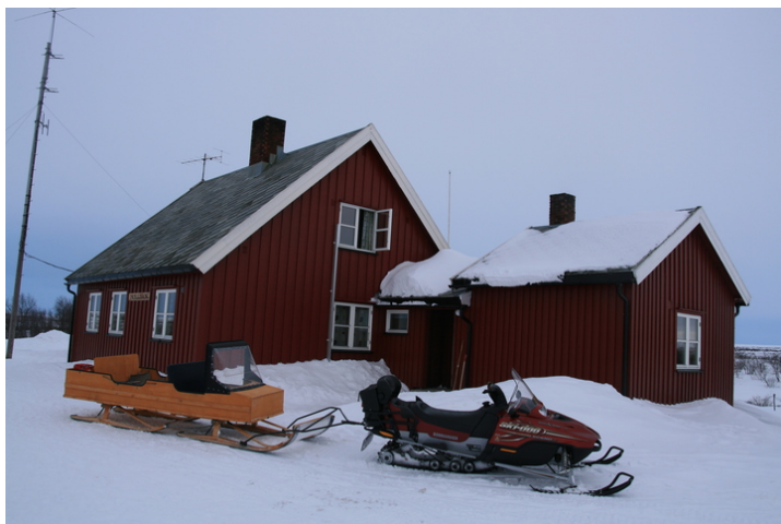
Oppsitterbolig med folkestue bygget inntil. Fasader mot nordøst. Opphavsrett: Statsbygg.
