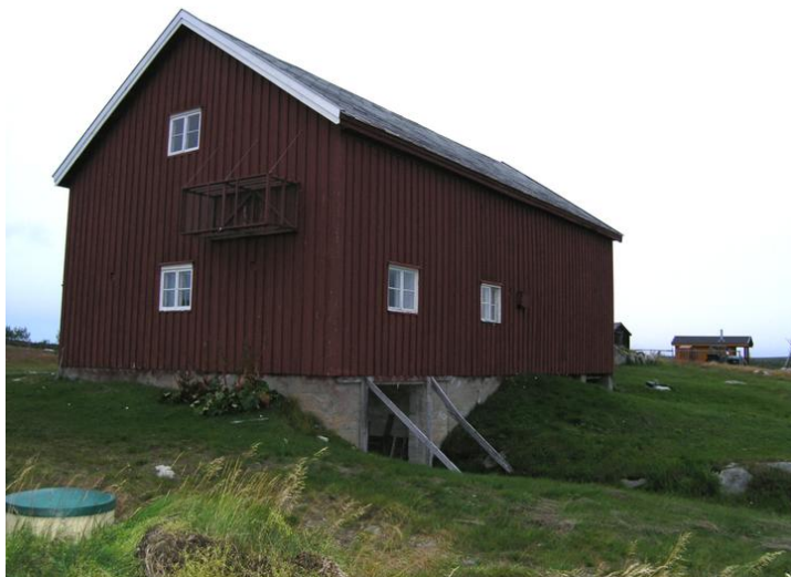
Driftsbygningens fasade mot sør. Opphavsrett: Statsbygg.
