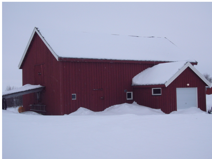
Fasade mot nord. Opphavsrett: Statsbygg.
