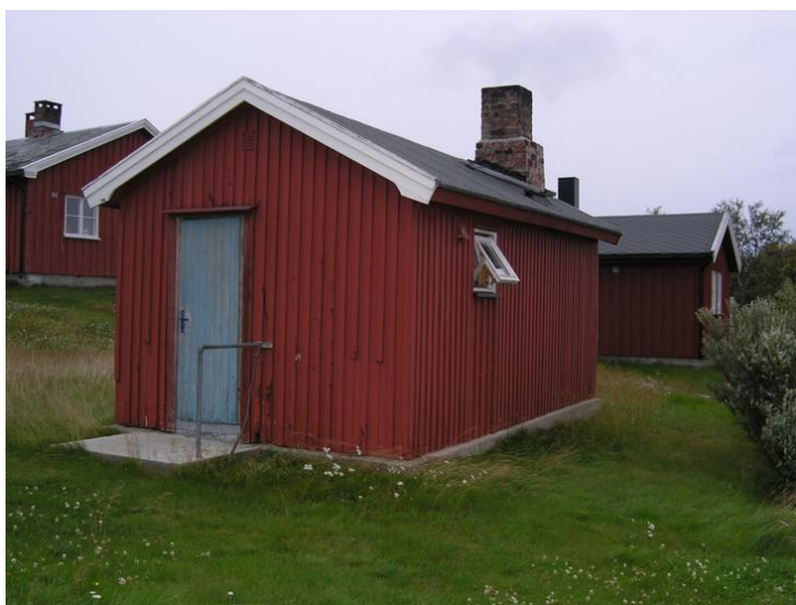
Fasade sørvest, inngangsparti. Opphavsrett: Statsbygg.
