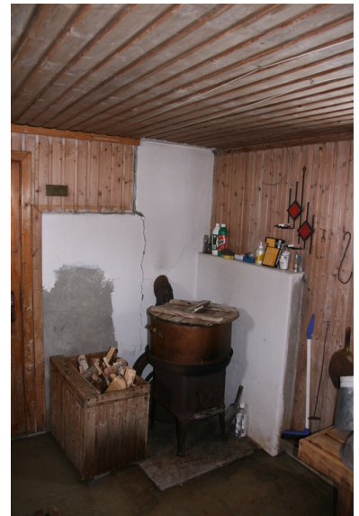
Ovn med kjele. Opphavsrett: Statsbygg.
