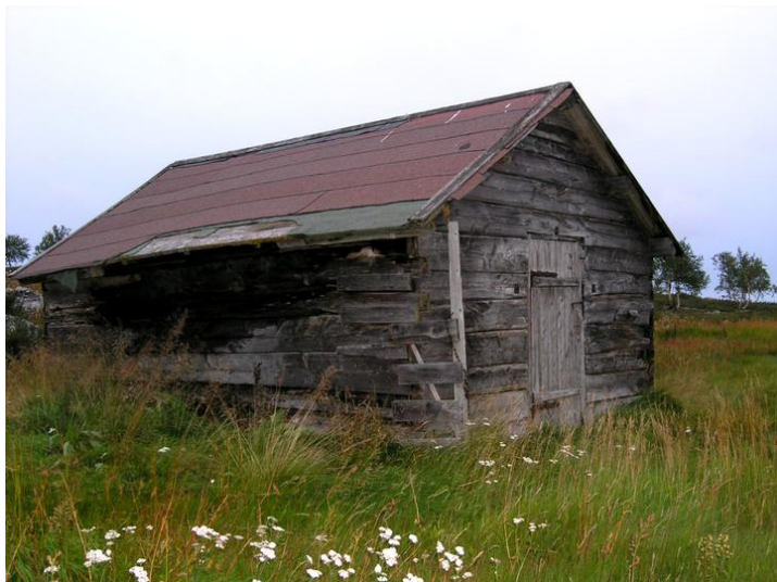
Fasade med inngang som vender mot sørvest og øvrig bebyggelse. Opphavsrett: Statsbygg.
