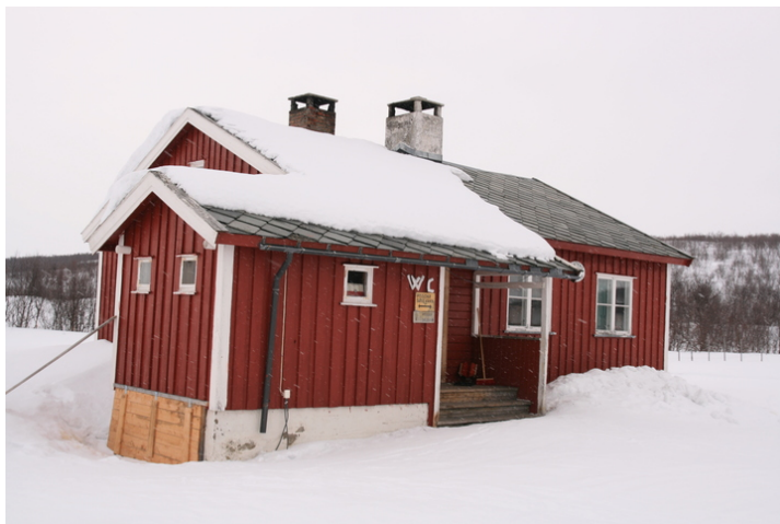
Nyere tilbygg for toaletter i forgrunnen. Opphavsrett: Statsbygg.
