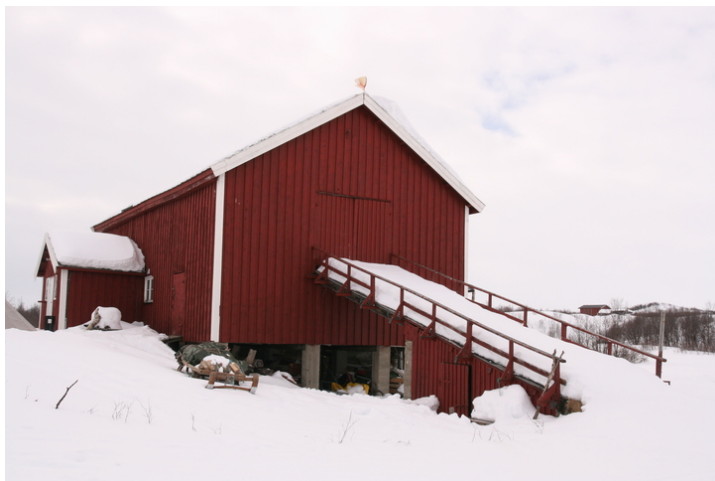
Driftsbygning med låvebru. Opphavsrett: Statsbygg.
