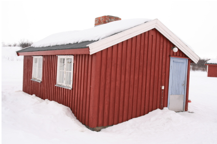
Folkestue var opprinnelig vedsjå/uthus. Opphavsrett: Statsbygg.
