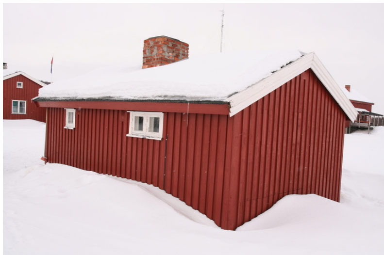
Folkestua. Driftsbygningen skimtes til høyre i bakgrunnen og gjestestua til venstre. Opphavsrett: Statsbygg.
