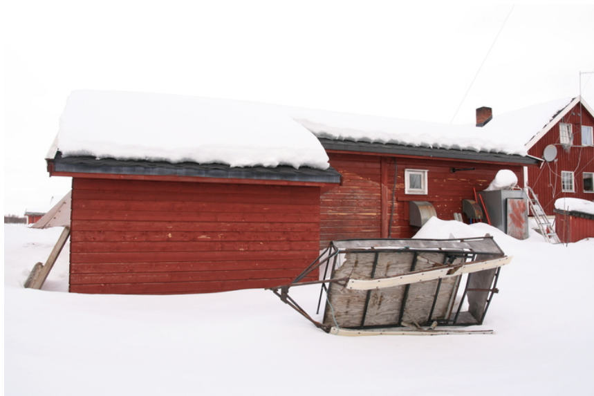
Vedsjåen ligger mellom oppsitterboligen og driftsbygningen. Opphavsrett: Statsbygg.
