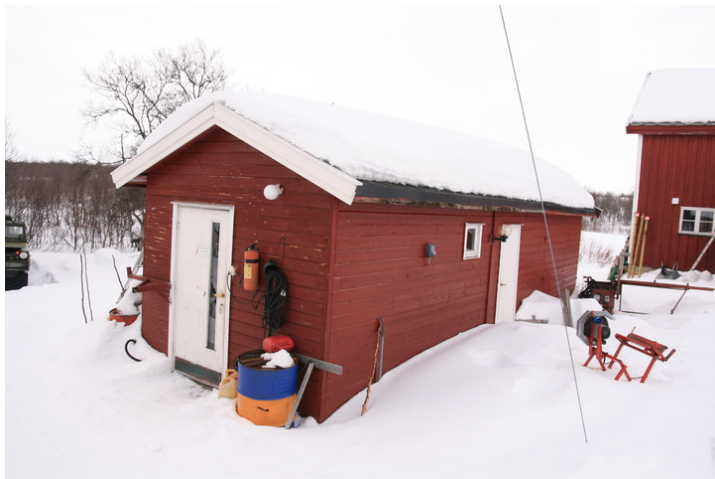
Et aggregatrom er bygget til den opprinnelige vedsjåen. Opphavsrett: Statsbygg.
