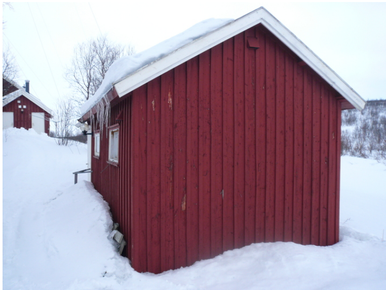
Badstuas gavlvegg mot vest. Opphavsrett: Statsbygg.
