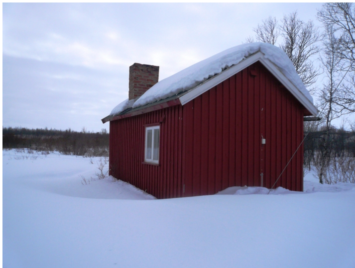
Gavlvegg mot vest og langvegg mot nord. Opphavsrett: Statsbygg.
