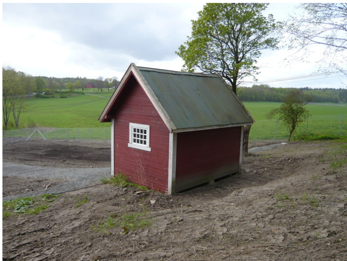
Langvegg mot nord. En av de større driftsbygningene på kongsgården skimtes i bakgrunnen. Opphavsrett: Statsbygg.
