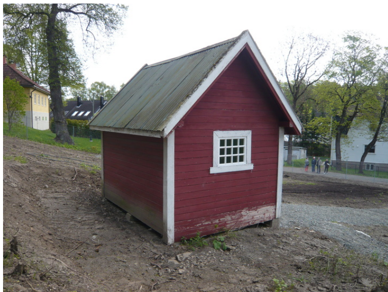
Gavlvegg mot vest. Opphavsrett: Statsbygg.
