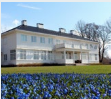
Foto: Staur gård
