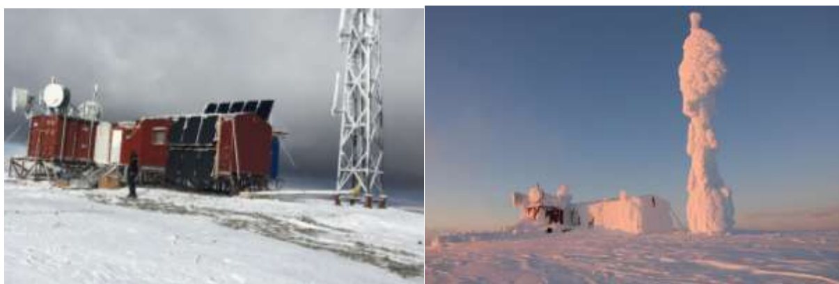
Figur 38: Solcellene på skolten gir strøm til Telenors antenneanlegg. Dette anlegget er uten tilknytting til nett og solkraften erstatter diesel. På vinteren kan solcellene bli pakket inn i snø og is, men når sola kommer tilbake starter produksjonen igjen uten problemer. (Foto: Johannes Drægri, Telenor)
