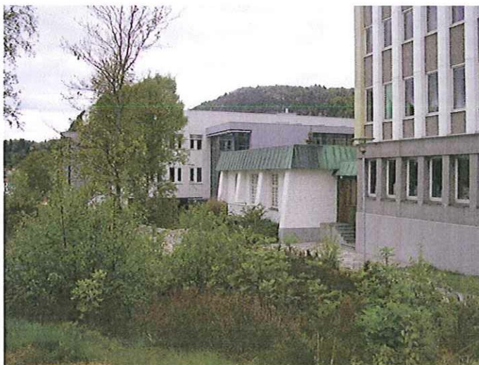
Stupet, fasade mot sør-vest. Høyblokk til høyre, og servicebygg til venstre. Opphavsrett: Statsbygg.
