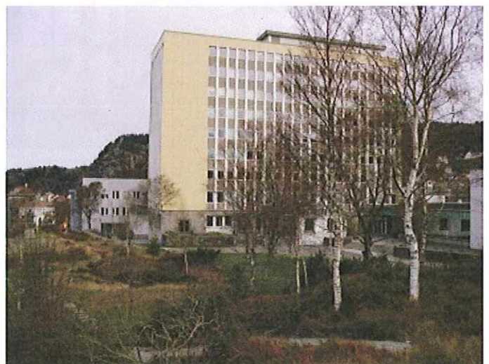
Høyblokk sett fra sør. Service i bakgrunn på venstre side. Opphavsrett: Statsbygg.
