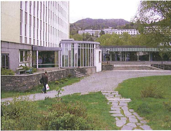
Hovedbygning, fasade mot vest. Høyblokk og kommunikasjonslinje til høyre. Studenthjemmet Hatleberg i bakgrunnen. Opphavsrett: Statsbygg.
