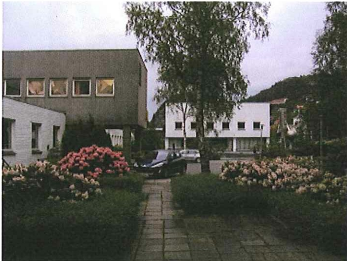
Hovedadkomst sett fra Auditoriefløy. Hovedinngang til høyre, Aula i bakgrunnen. (nb. opprinnelige vinduer i bygg over hovedinngang) Opphavsrett: Statsbygg.
