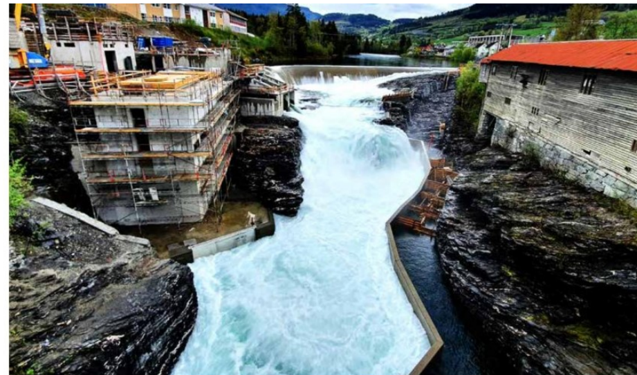
Det er et imponerende arbeid som utføres i Palmafossen når en unik toveis vandringssløsning skal på plass.
