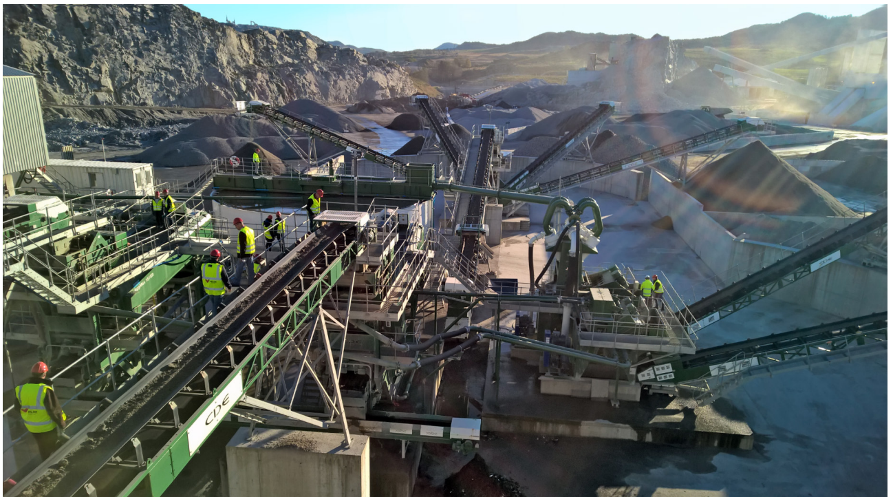
Figur 14.2 Miljøanlegget på Velde som vasker og sorterer gravemasser og gir tilbake høyverdige råstoffer som ellers hadde blitt deponert.
