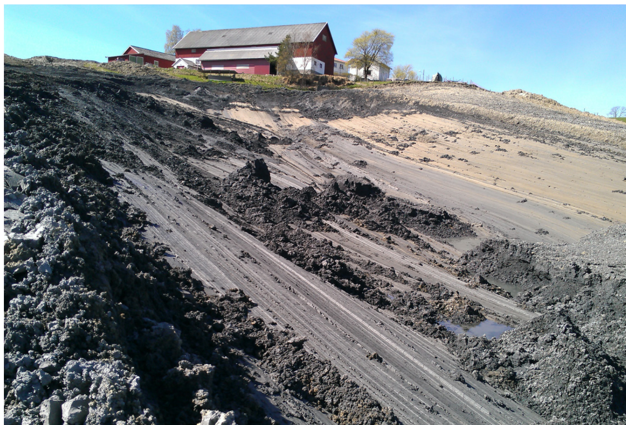
Figur 9.1 Massehåndtering krever god kontroll med mange forhold, herunder grunnforhold. På bildet over skapte leire i grunnen uforutsette utglidninger som følge av tilførsel av jordmasser på frossen leire (ikke kvikkleireskred).
