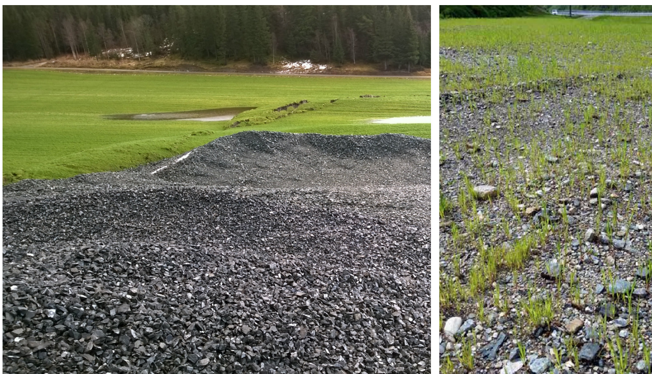
Figur 9.2 To eksempler som synliggjør hvordan det kan gå når 1) Man «bare skal mellomlagre» på dyrka jord (bilde til venstre), og 2) Når toppdekket og oppbyggingen av lagene ikke ivaretar ønsket kvalitet (bilde til høyre).
