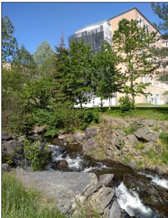
Figur 42. Naturlig uttrykk på bekketrasé som ble bygget for 20 år siden (himmelretning: mot nord-øst).
