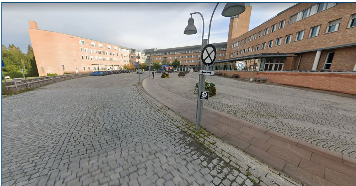
Figur 29: Eksisterende atkomstplass med belegningsstein. Bildet hentet fra Google Street View.
