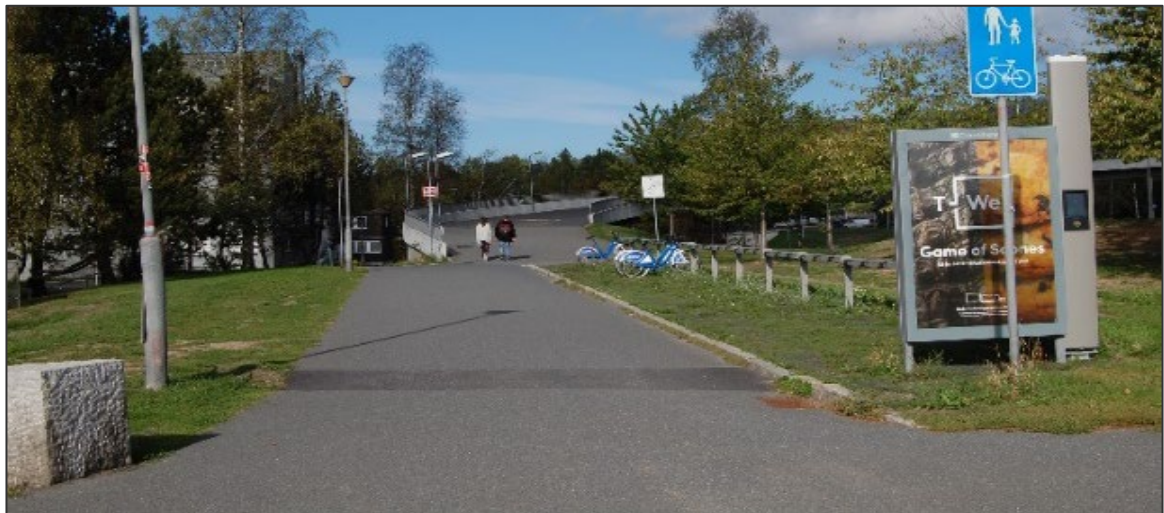
Figur 2: Sør for Ring 3, retning vest på vei opp broen.
