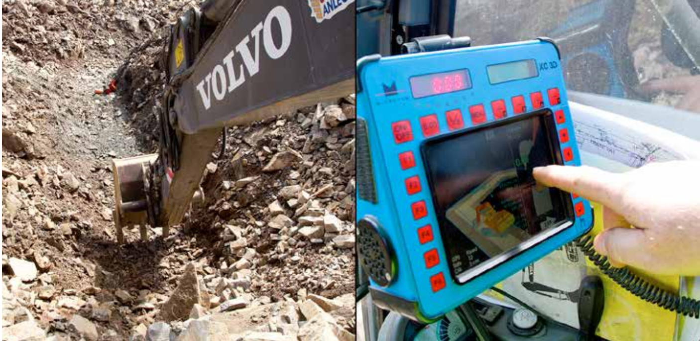
Muligheter for nøyaktig posisjonering er av stor betydning innen bygg og anleggsvirksomhet.
