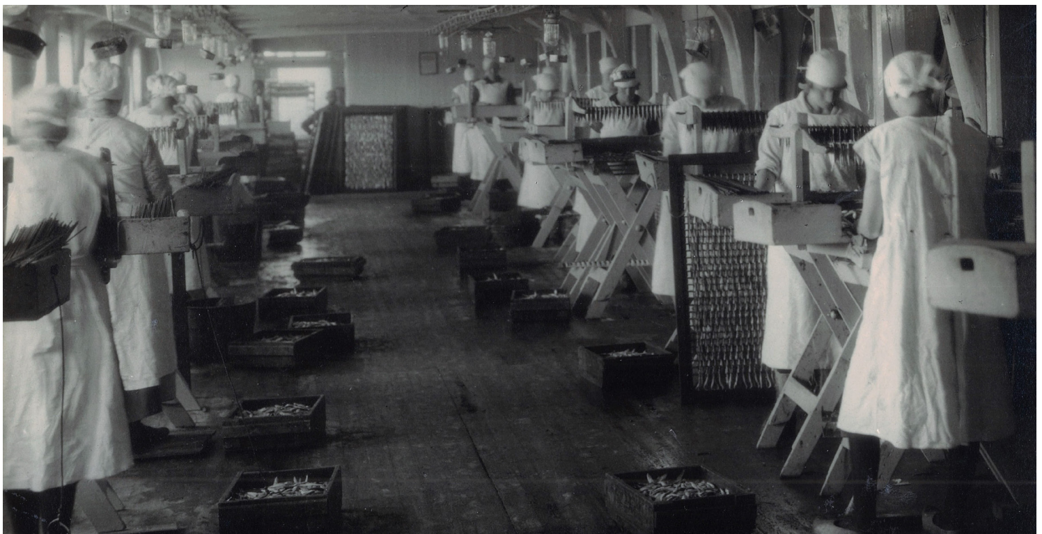
Hermetikkindustri, Stavanger 1909. Lønna var lav, og fabrikklokala var ofte kalde og helseskadelege.
