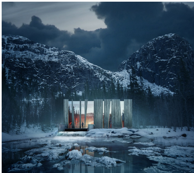
Øvre Forsland Kraftverk, Leirfjord Helgeland Kraft AS Åpnet av Tord Lien august 2015
