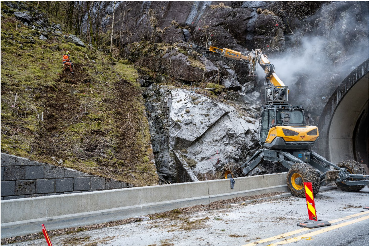
Skredsikring E134 Fjæra. Foto: Bård Asle Nordbø/Statens vegvesen
