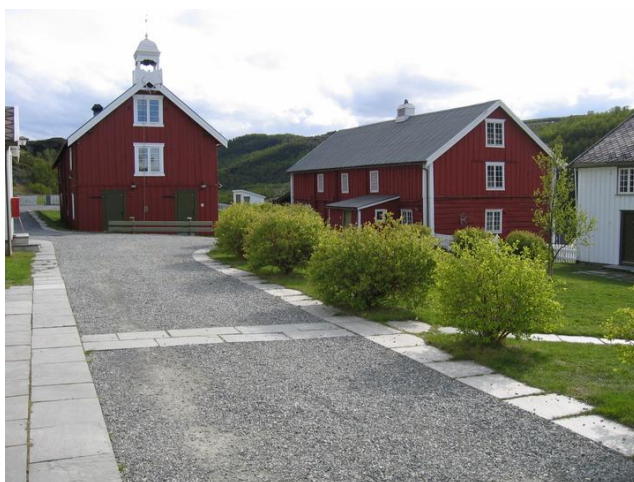
Tunet sett mot raudlåna Foto: Trude Norddal Opphavsrett: Statsbygg
