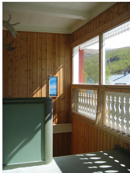
Svalgangeren er klimatisert, og trappen opp fra 1. etasje snudd. Sveitserstildetaljer er bevart, det samme er himlingen. Foto: Trude Norddal Opphavsrett: Statsbygg
