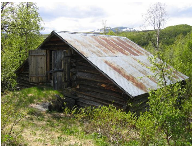
Østfasade Foto: Trude Norddal Opphavsrett: Statsbygg
