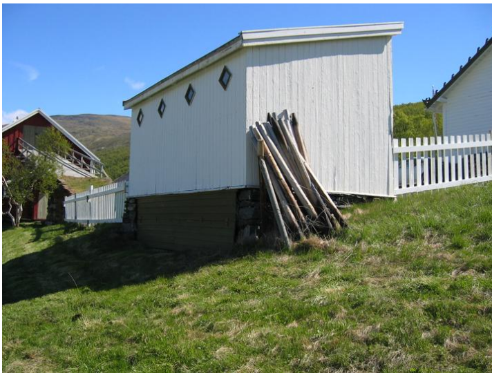
Sør- og vestfasade Foto: Trude Norddal Ophavsrett: Statsbygg
