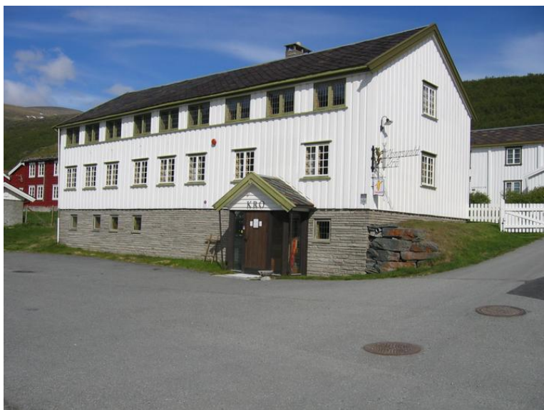
Vest- og nordfasade Foto: Trude Norddal Opphavsrett: Statsbygg
