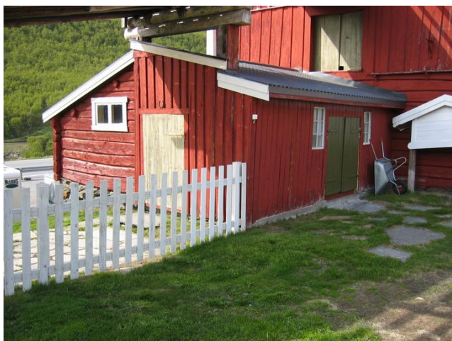
Sauefjøsset og det nye avfallsrommet Foto: Trude Norddal Opphavsrett: Statsbygg
