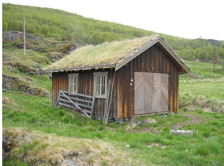
Nord- og vestfasade Foto: Trude Norddal Opphavsrett: Statsbygg
