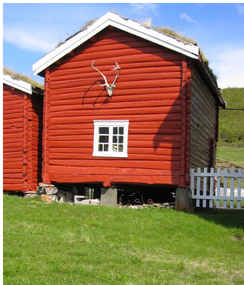
Sør- og vestfasade Foto: Trude Norddal Ophavsrett: Statsbygg
