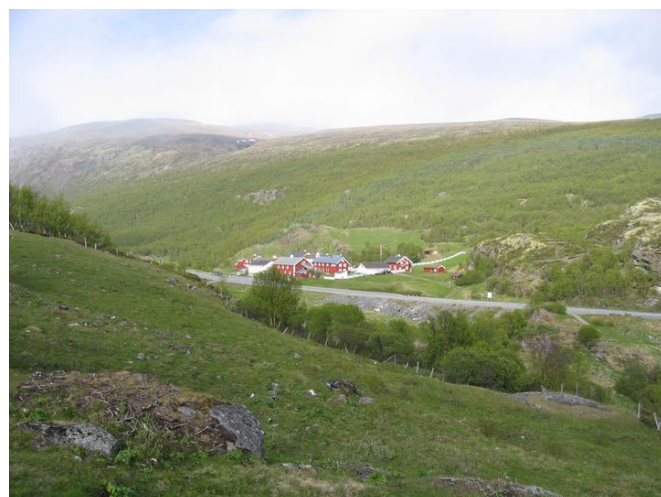
Kongsvold sett fra sørvest Foto: Trude Norddal Opphavsrett: Statsbygg
