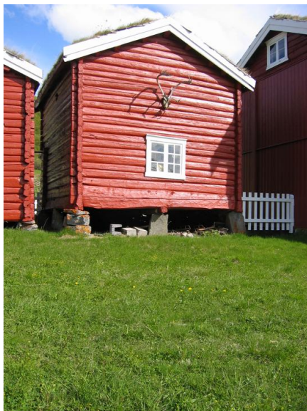
Nord- og vestfasade Foto: Trude Norddal Ophavsrett: Statsbygg
