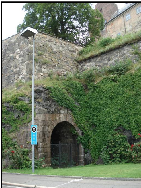
Romeriksbastionen rager over Akershusstranden. Stein er løse og kan falle ned. (Foto: Mur-sentret AS 2007)
