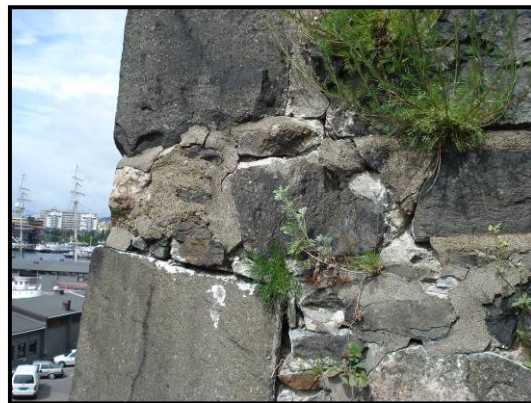
Romeriksbastionen rager over Akershusstranden. Stein er løse og kan falle ned. (Foto: Mur-sentret AS 2007)
