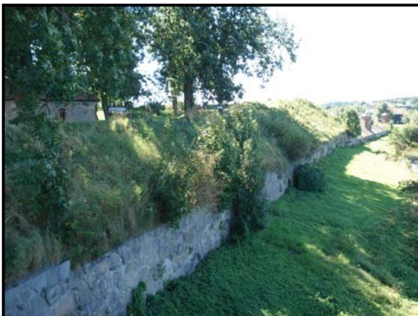
Prins Georgs halvbastion i Fredrikstad er et godt eksempel på hvordan festningsvoller gror igjen med kratt om de ikke skjøttes. (Foto: Mur-sentret 2007)
