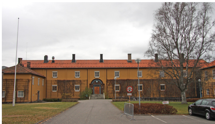
Hovedadkomsten. Opphavsrett: Statsbygg.
