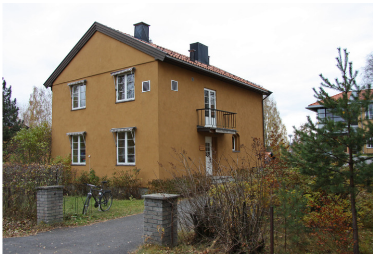
Fasade mot nord og øst. Opphavsrett: Statsbygg.
