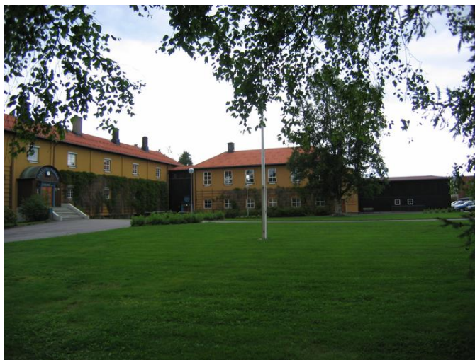
Fasade mot syd Opphavsrett: Statsbygg.
