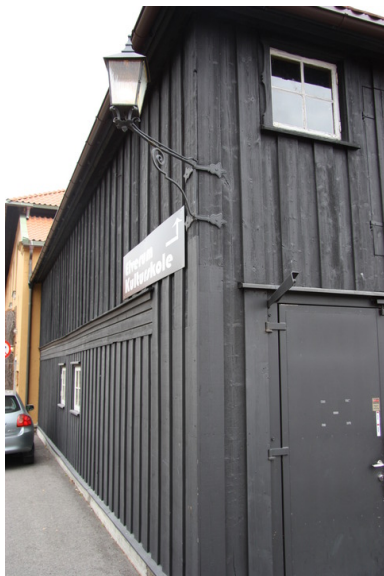
Opprinnelig var fasaden t.v. i 1. etasje åpen, trolig som uværsskur. Opphavsrett: Statsbygg.
