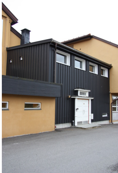
Inngangsparti for aulaen. Opphavsrett: Statsbygg.
