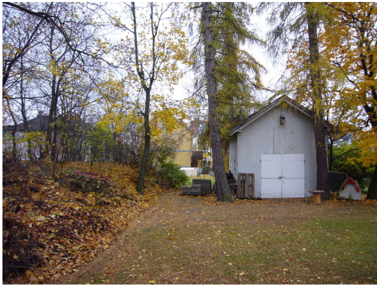
Lagerbygg. Opphavsrett: Statsbygg.
