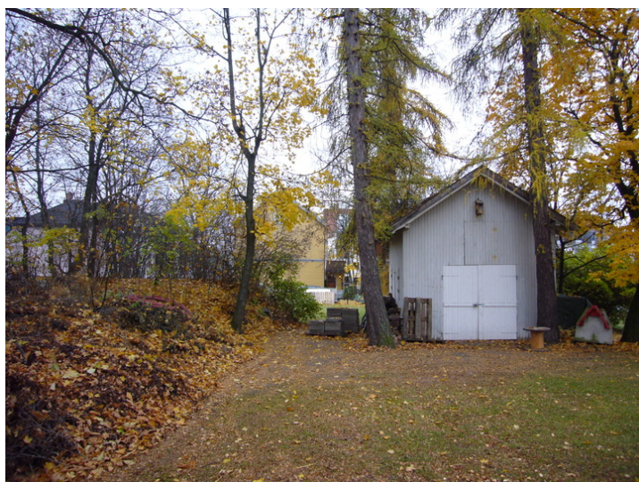
Lagerhus. Opphavsrett: Statsbygg.
