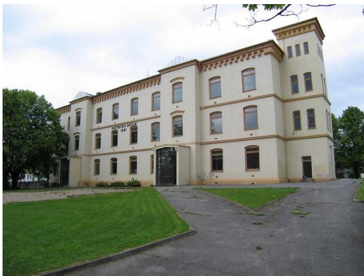
Fasade mot syd og vest Opphavsrett: Statsbygg.
