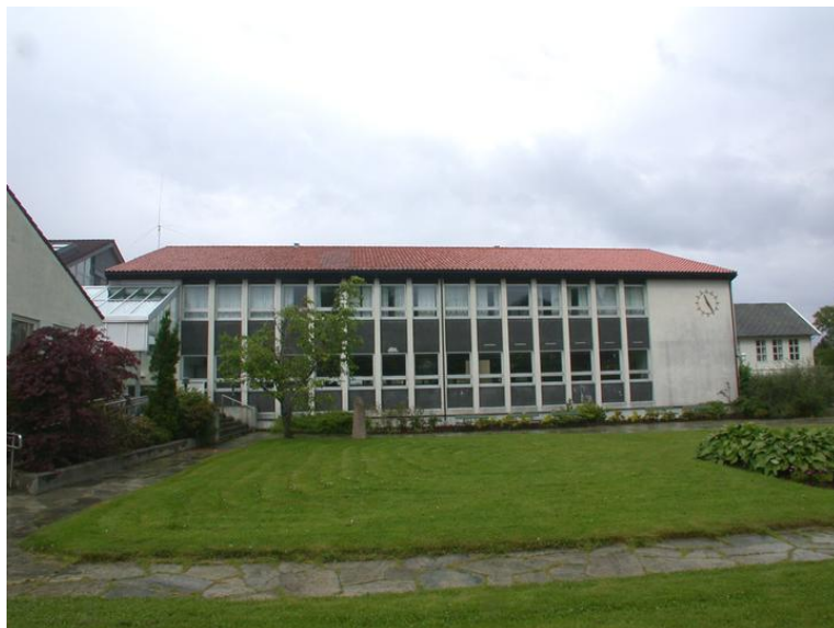
Fasade sørvest Opphavsrett: Statsbygg
