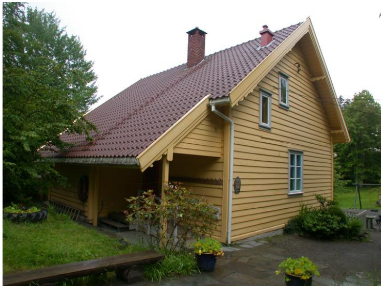
Fasade nord. Opphavsrett: Statsbygg
