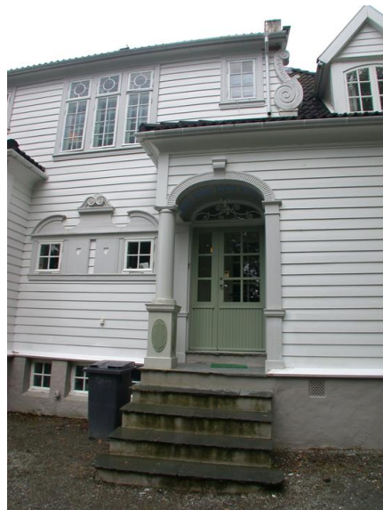
Inngangsparti. Opphavsrett: Statsbygg
