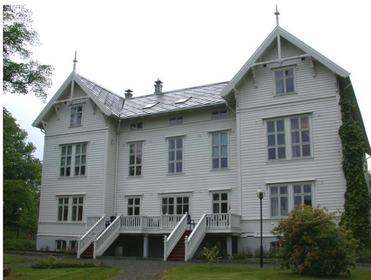
Fasade sørøst, mot seminarhagen. Opphavsrett: Statsbygg
