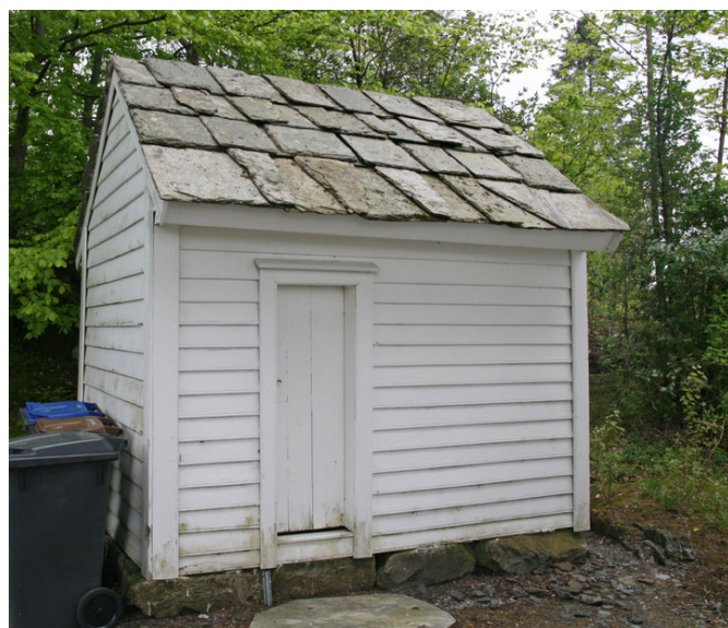
Uthus til skolestua. Opphavsrett: Statsbygg
