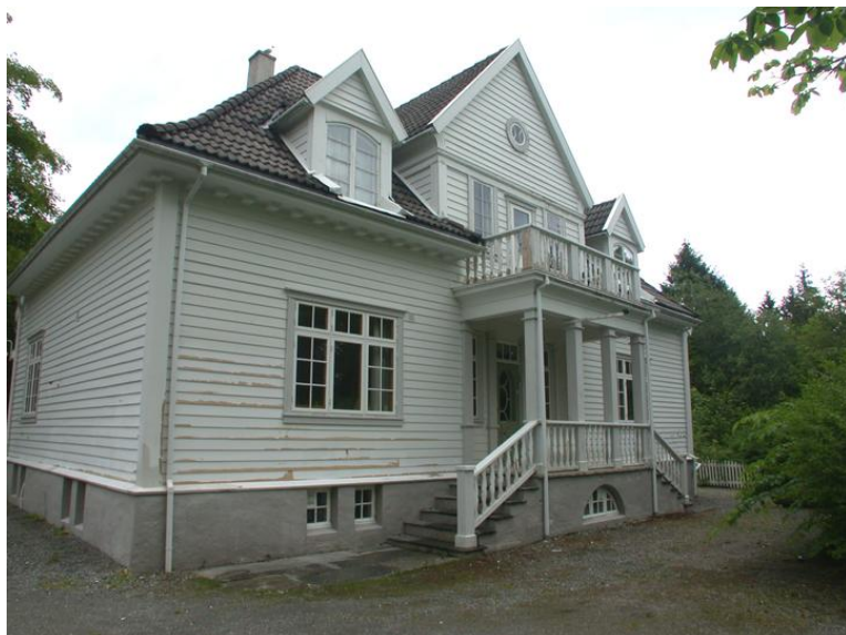
Fasade sørøst. Opphavsrett: Statsbygg
