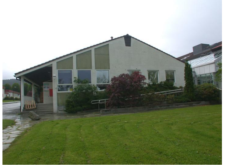
Fasade sørøst Opphavsrett: Statsbygg
