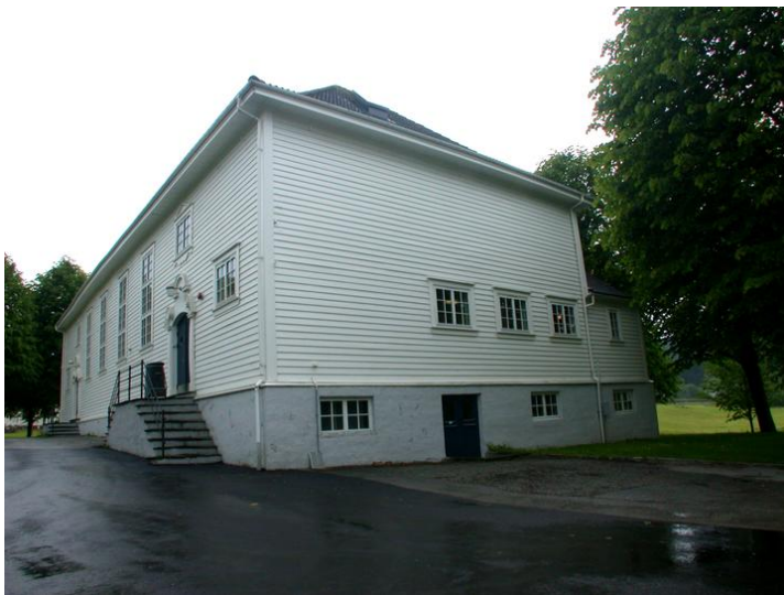
Fasade nord. Opphavsrett: Statsbygg
