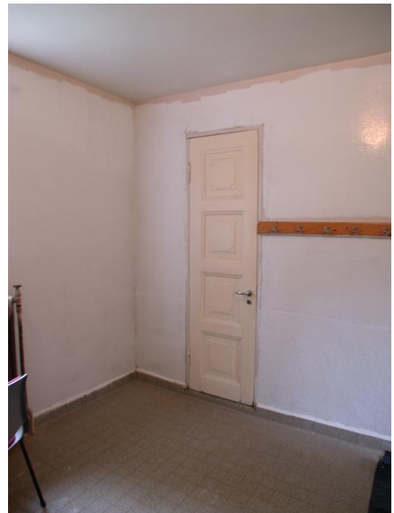
Garderobe. Opphavsrett: Statbygg
