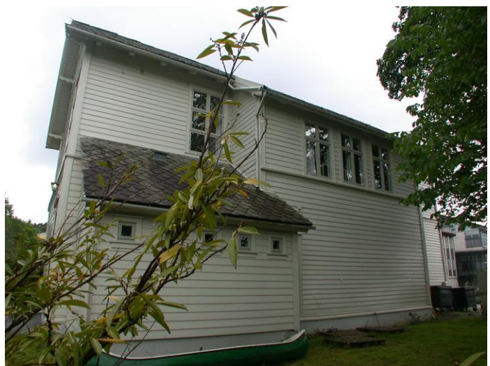
Fasade mot nordvest. Opphavsrett: Statsbygg
