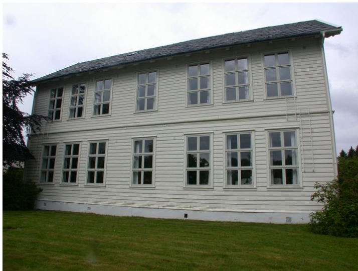
Fasade sørvest. Opphavsrett: Statsbygg
