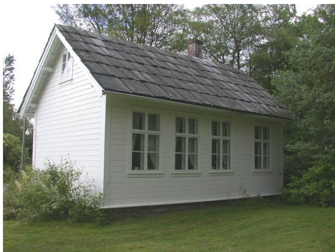
Fasade sørvest. Opphavsrett: Statsbygg
