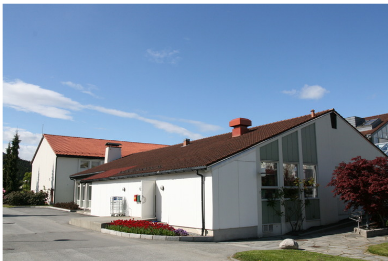
Aula bak til venstre, forbundet med velferdsbygningen i forgrunnen. Opphavsrett: Statsbygg
