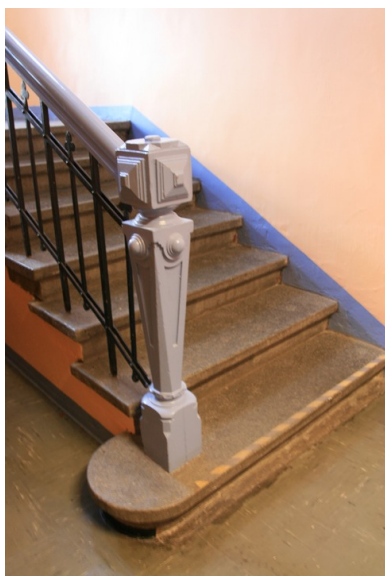
Trapp i 1904-bygningen. Opphavsrett: Statsbygg.
