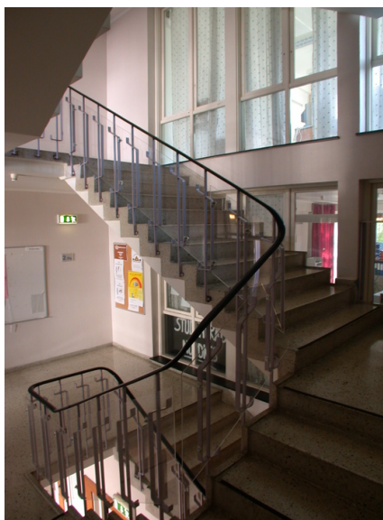
Hovedtrapp i 1960-bygningen. Opphavsrett: Statsbygg.
