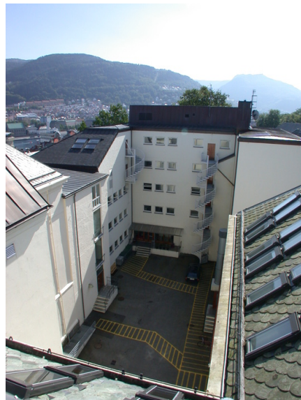
Tak på nybygg sett fra det gamle bygget. Opphavsrett: Statsbygg.
