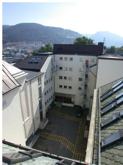
Fasader bakgård mot sørøst Foto: Ann- Kristin Strømmen Opphavsrett: Statsbygg
