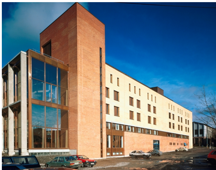
Fasaden mot Politi høyskolen. Foto: Teigens fotoatelier AS. Opphavsrett: Teigens fotoatelier AS.
