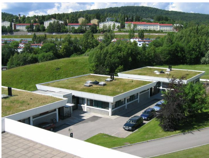
Taket på grønnstua mellom Rødstua og Gulstua. Opphavsrett: Statsbygg.
