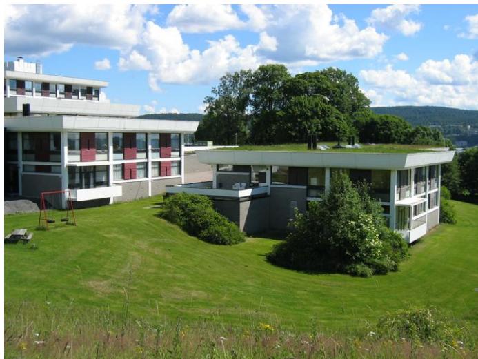
Nordvest fasade. Rødstua venstre Opphavsrett: Statsbygg.
