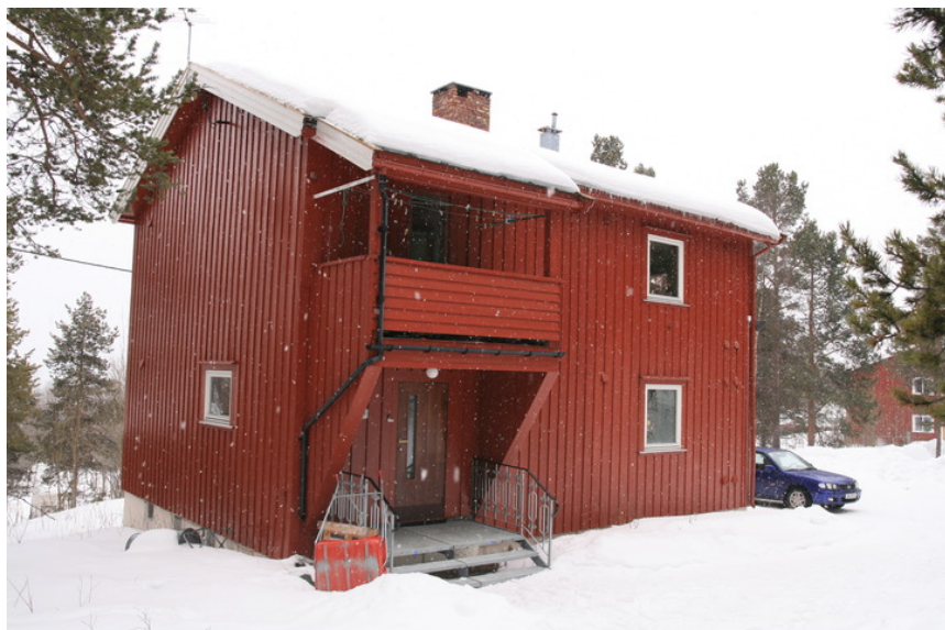
Nøkkeltien 9 A og B. Opphavsrett: Statsbygg.
