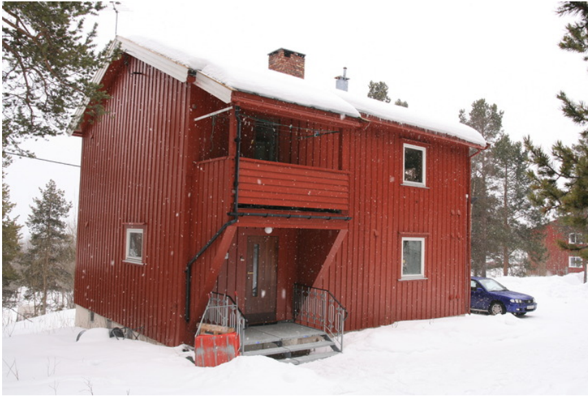
Inngangsparti. Opphavsrett: Statsbygg.
