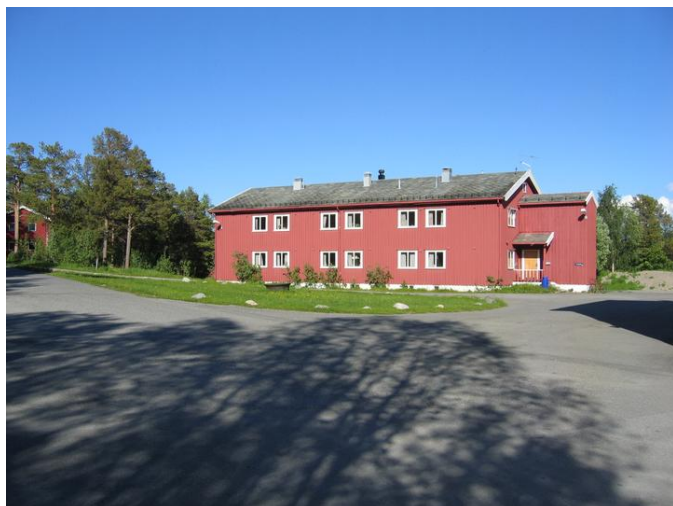
Fasade sørøst. Opphavsrett: Statsbygg.
