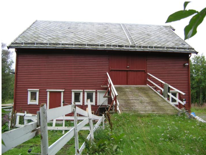
Fasade øst. Opphavsrett: Statsbygg.
