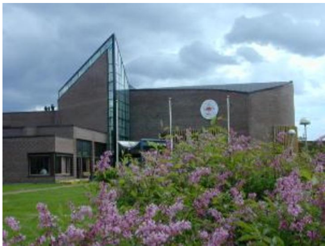
Hovedinngang byggetrinn 3. Opphavsrett: Høgskolen i Finnmark.
