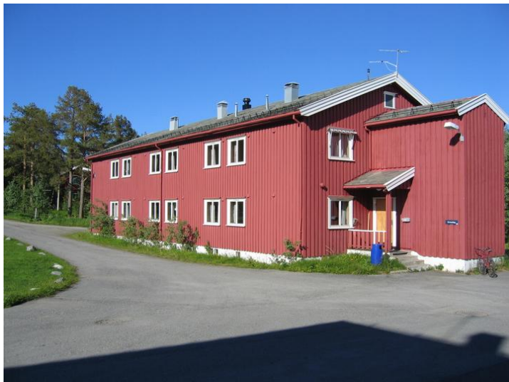
Fasade sørøst litt nærmere. Opphavsrett: Statsbygg.
