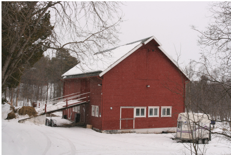
Fjøsbygningen mot hovedadkomst. Opphavsrett: Statsbygg.
