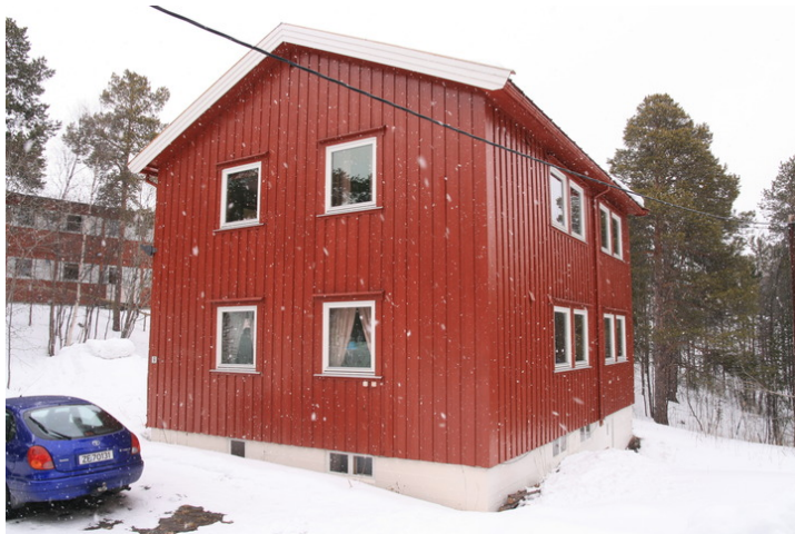
Nøkkelstien 9. Opphavsrett: Statsbygg.
