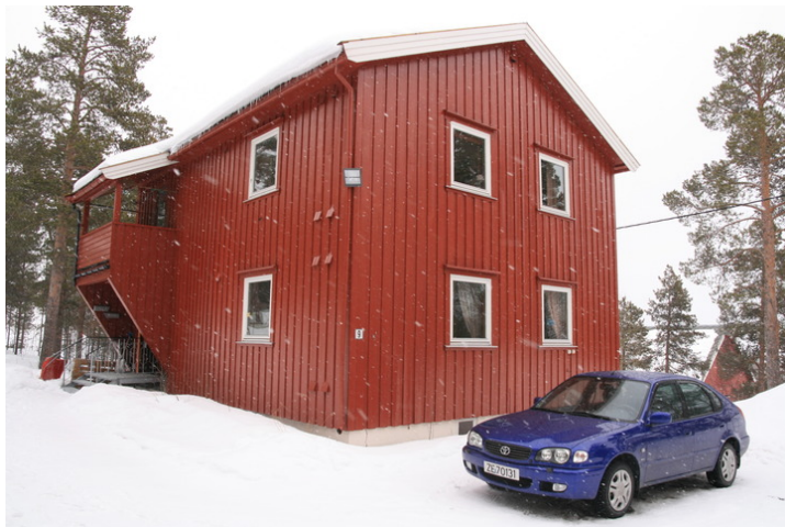
Nøkkelstien 9. Opphavsrett: Statsbygg.
