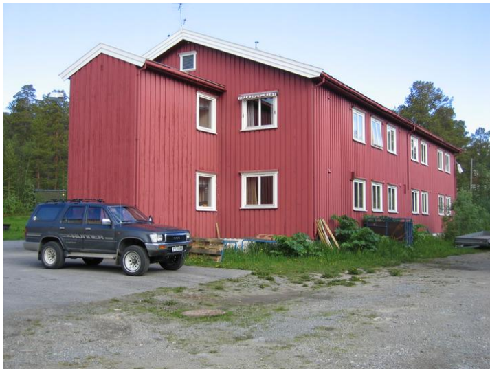
Fasade nord. Opphavsrett: Statsbygg.
