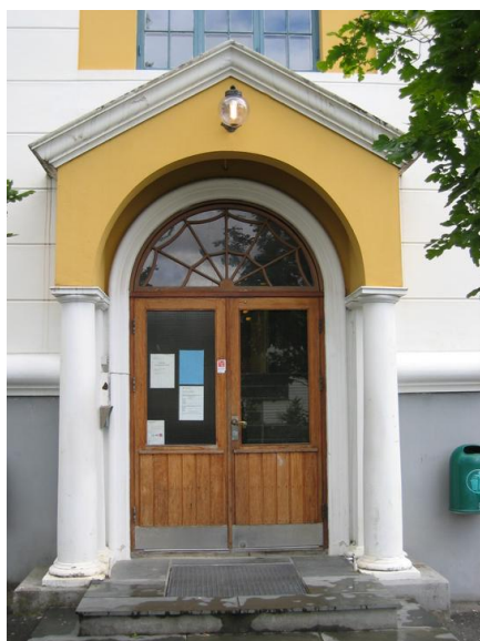
Vestre inngang. Foto: Einar Engen Opphavsrett: Statsbygg.
