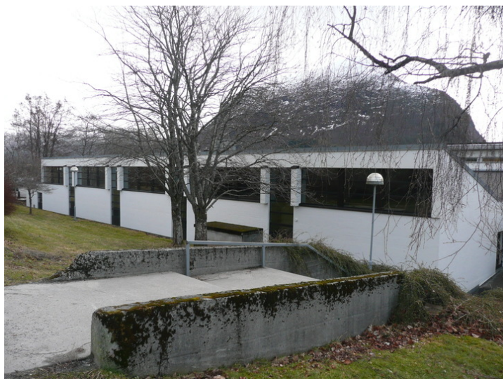
Lærerskoetilbygg fra 1982, fasade mot nord. Opphavsrett: Statsbygg.
