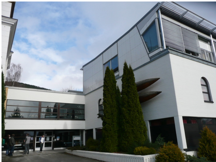
Tilbyggene fra 1982 og 2001. Opphavsrett: Statsbygg.
