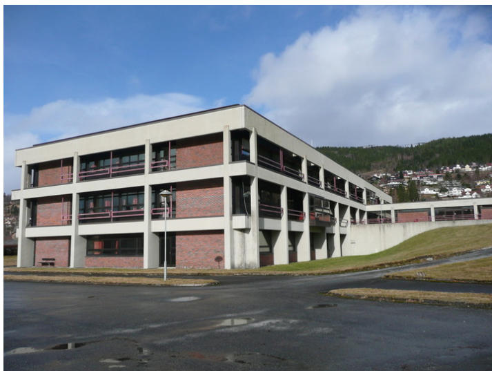
Hans Strømhuset. Opphavsrett: Statsbygg.
