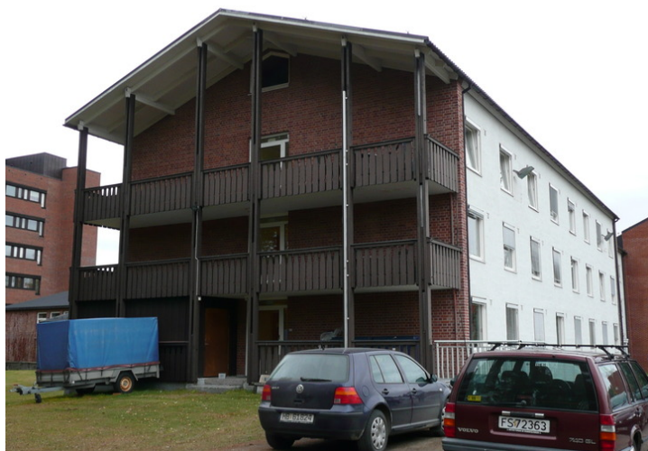
Sykepleierskole, Høgskolen i Hedmark Elverum. Opphavsrett: Statsbygg.
