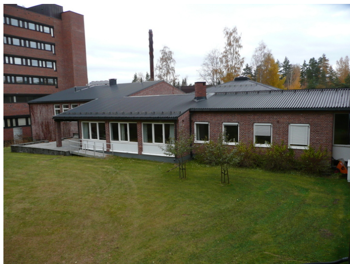
Undervisningsfløyen fra 1957. Opphavsrett: Statsbygg.
