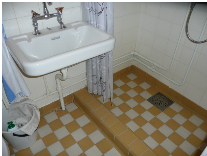
Bad i leilighet i internatet. Opphavsrett: Statsbygg.
