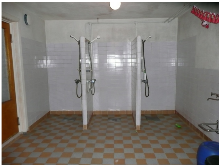
Garderobe med badstu i kjeller. Opphavsrett: Statsbygg.
